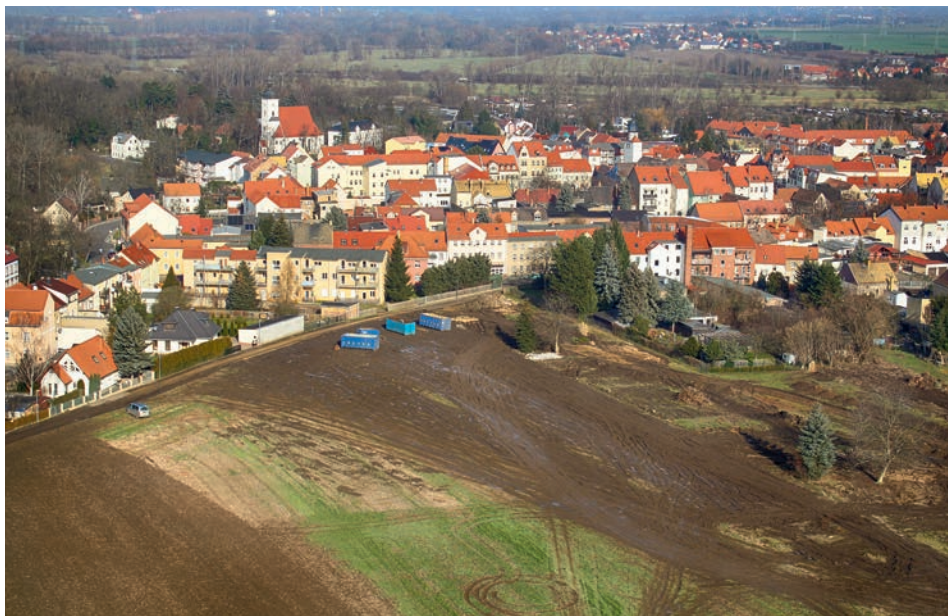
Das Wohngebiet Schiefer Weg in Groitzsch kurz vor dem Start der Erschließungsarbeiten.
